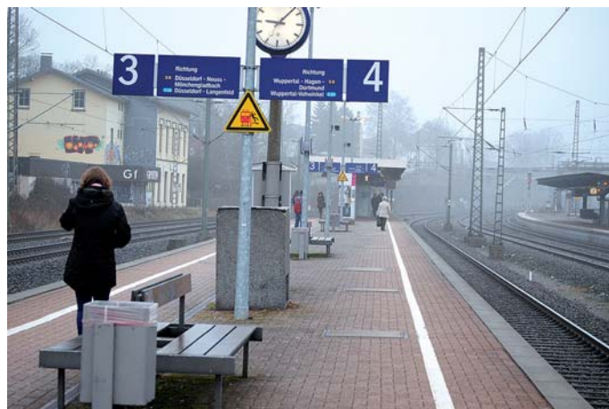
Es gibt bislang keinen barrierefreien Zugang zum Mittelgleis. Mit etwa 3000 Reisenden pro Tag ist der Bahnhof Gruitener kein kleiner Bahnhof.
