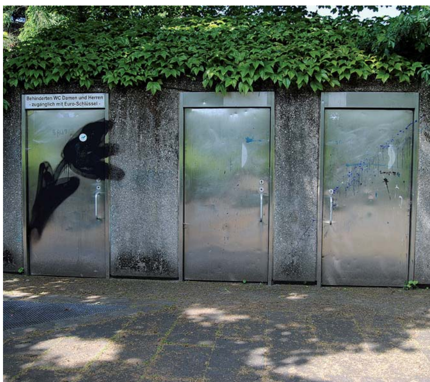
Seit zehn Jahren sind die öffentlichen Toiletten am Windhövel geschlossen. Ihre Sanierung ist für die Stadt zu teuer.
