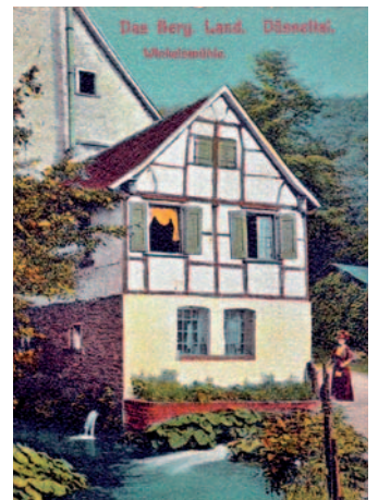
In den 1970er Jahren wurde das abbruchreife und durch einen Dachstuhlbrand zerstörte Gebäude zum Eigentum des Zweckverbandes Neandertal. Mittlerweile ist die Mühle wieder Privateigentum.
