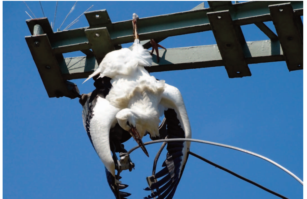
Mittelspannungsmasten stellen für Vögel eine tödliche Gefahr dar, wenn sie mit ihrem Körper stromführende Leitungen und Mastteile gleichzeitig berühren. Foto: Nabu
