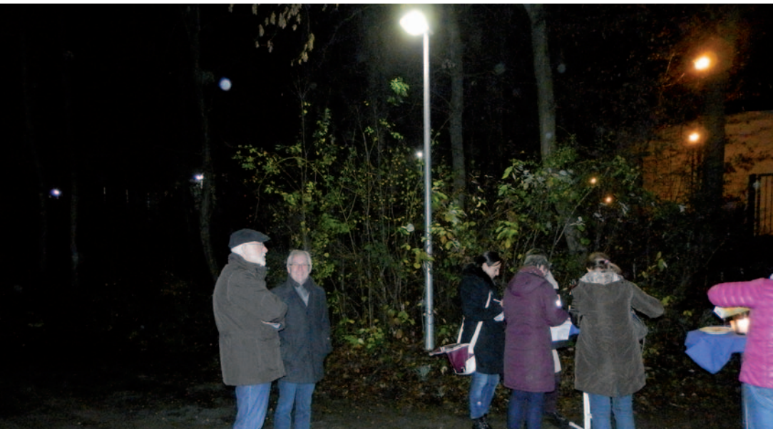
Jetzt mit Licht: Der Parkplatz der Sportanlage des TSV Gruiten erstrahlt nun auch am Abend nach der Installation von zwei Beleuchtungsmasten. Foto: Jürgen Boes
