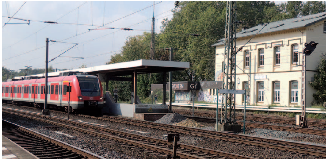
Der Kreis Mettmann hat im Rahmen des Bedarfsplans für den ÖPNV des Landes NRW den barrierefreien Zugang zum Gruitener Bahnhof als zu prüfende Maßnahme gemeldet. Foto: Maguire
