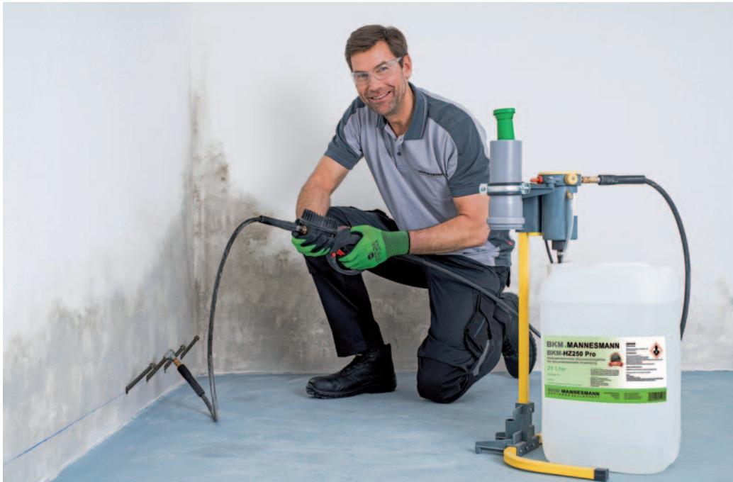
Mit einer Mauerwerksinjektion gehören feuchte Wände und Schimmelbildung der Vergangenheit an.
