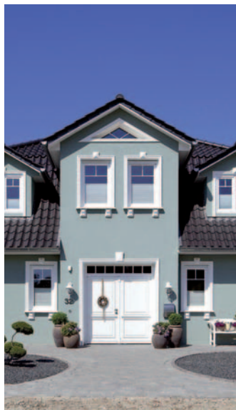
Bei der energetischen Sanierung eines Hauses geht es um eine Vielzahl von Themen. Vor allem aber geht es darum, die Lebensqualität der Bewohner zu steigern und dazu beizutragen, natürliche Ressourcen zu schützen.
