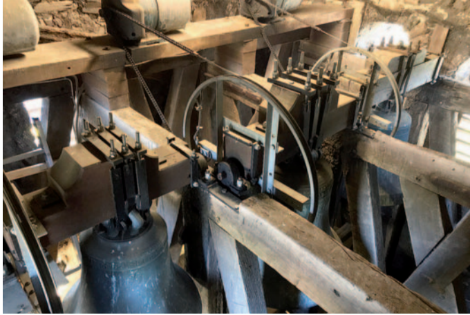
Die Balken des Glockenstuhls sind marode. Nun soll ein Holzgutachter beauftragt werden. Fotos (2): (privat)
