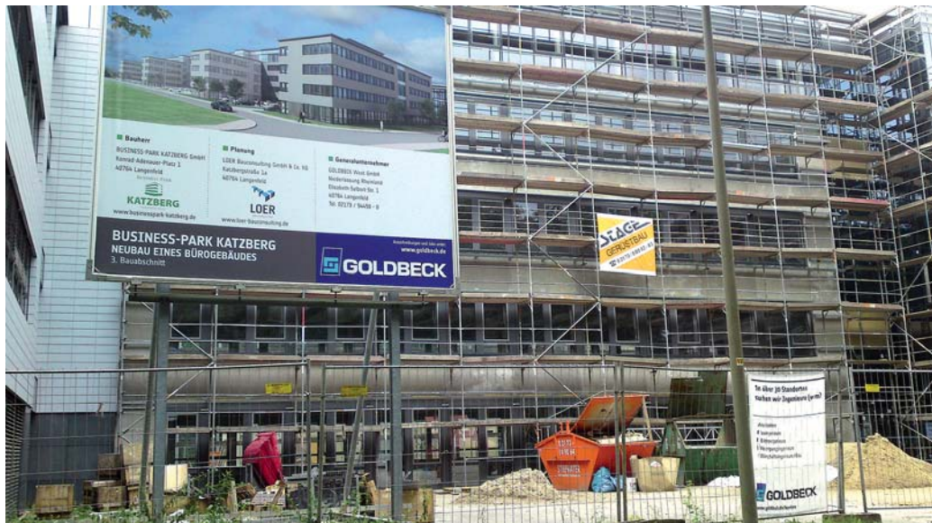
An der Katzbergstraße wird weiterhin munter gebaut. Der Business-Park Katzberg wurde 2004 gegründet, hier sitzen unter anderem Saltigo und Lanxess. Foto: Straub
