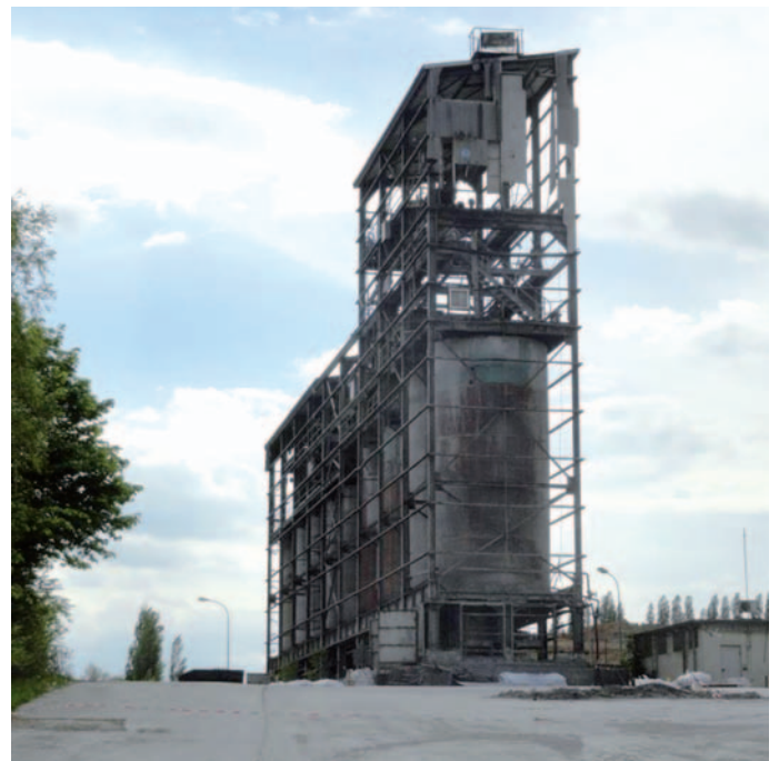
Die Siebanlage sollte eigentlich verschrottet werden.
