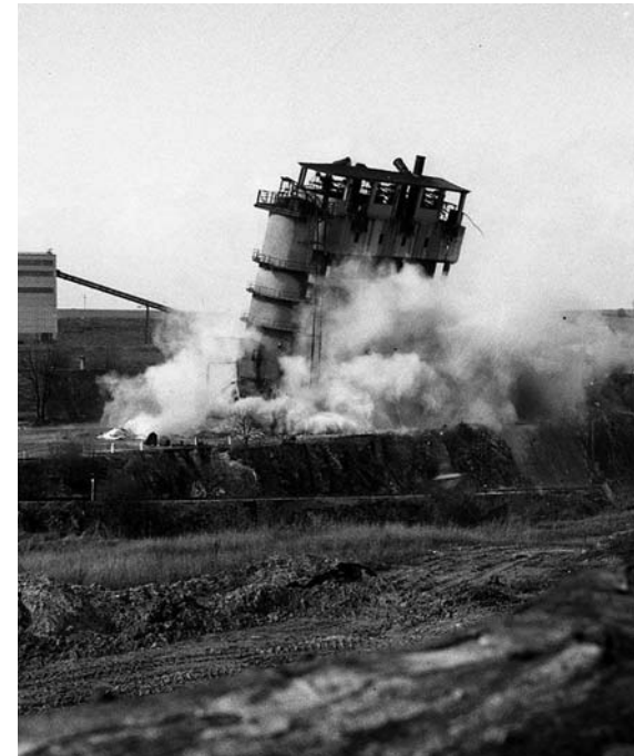
Als der alte Ringschachtofen der Kalksteinwerke Neandertal ausgedient hatte, wurde er in den 1960er Jahren gesprengt. Repros(3): Mikko Schümmelfeder
