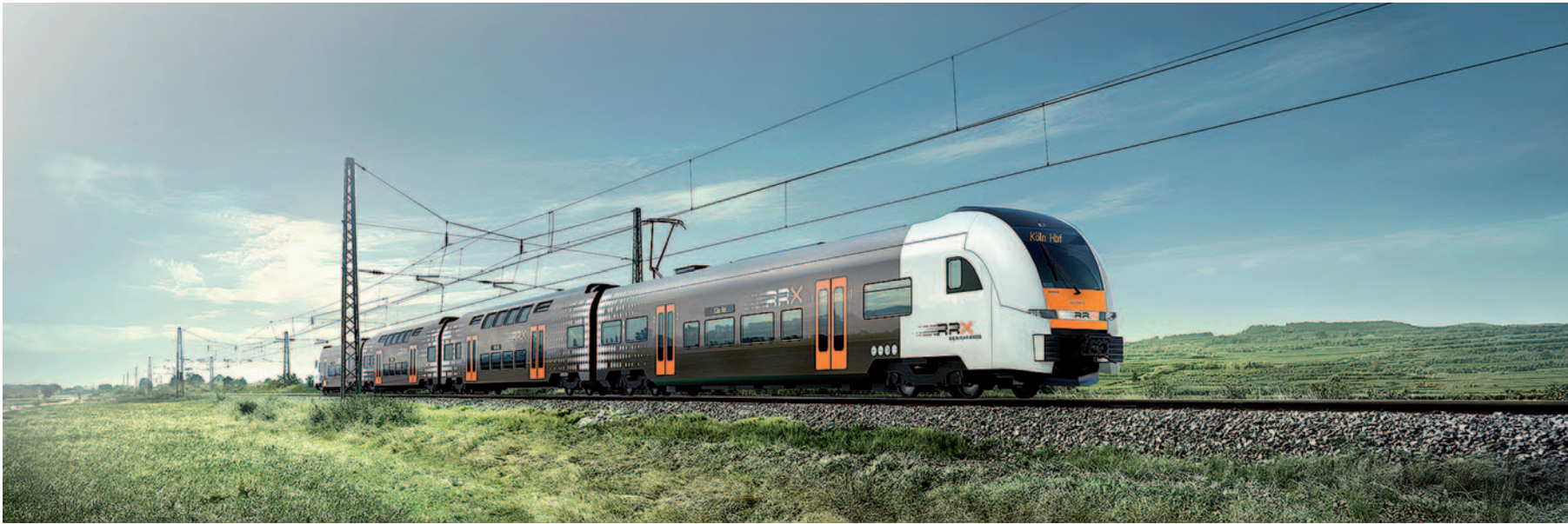
Am 25. März 2019 wurde durch das Eisenbahnbundesamt der Planfeststellungsbeschluss für den Rhein-Ruhr-Express im Stadtgebiet von Langenfeld gefasst.
