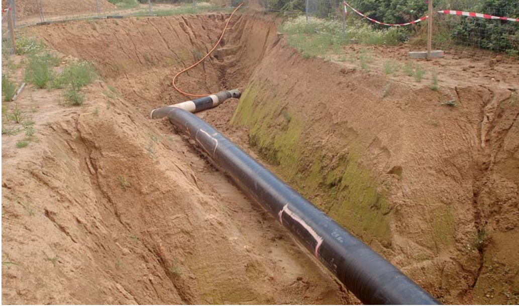
Die umstrittene CO-Pipeline (Foto) beschäftigte das Verwaltungsgericht Düsseldorf. In Monheim wurde unlängst ein in sich verknottetes und von Erwin Schumacher konstruiertes Stahlrohr an der Opladener Straße als Mahnmahl gegen die Rohrleitung eingeweiht. Foto: Hildebrandt
