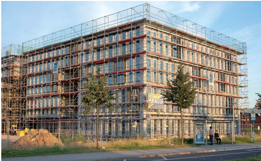
Hier, am Fuße des MonBergs, entsteht das Rheinpark-Carree.
