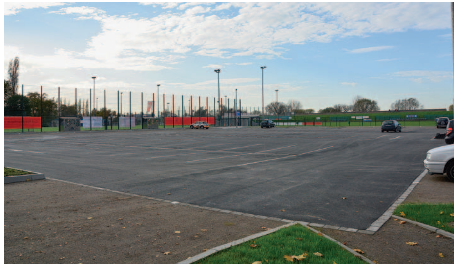
Nachher: So sieht der inzwischen fertig gestellte Parkplatz am Monheimer Rheinstadion aus. Der für jedermann nutzbare neue Parkplatz bietet 121 Stellplätze. So freuen sich nicht nur die Sportfreunde, sondern auch Rheinspaziergänger, Besucher des „Sojus 7“ oder weitere Gäste. Foto: Stadt Monheim
