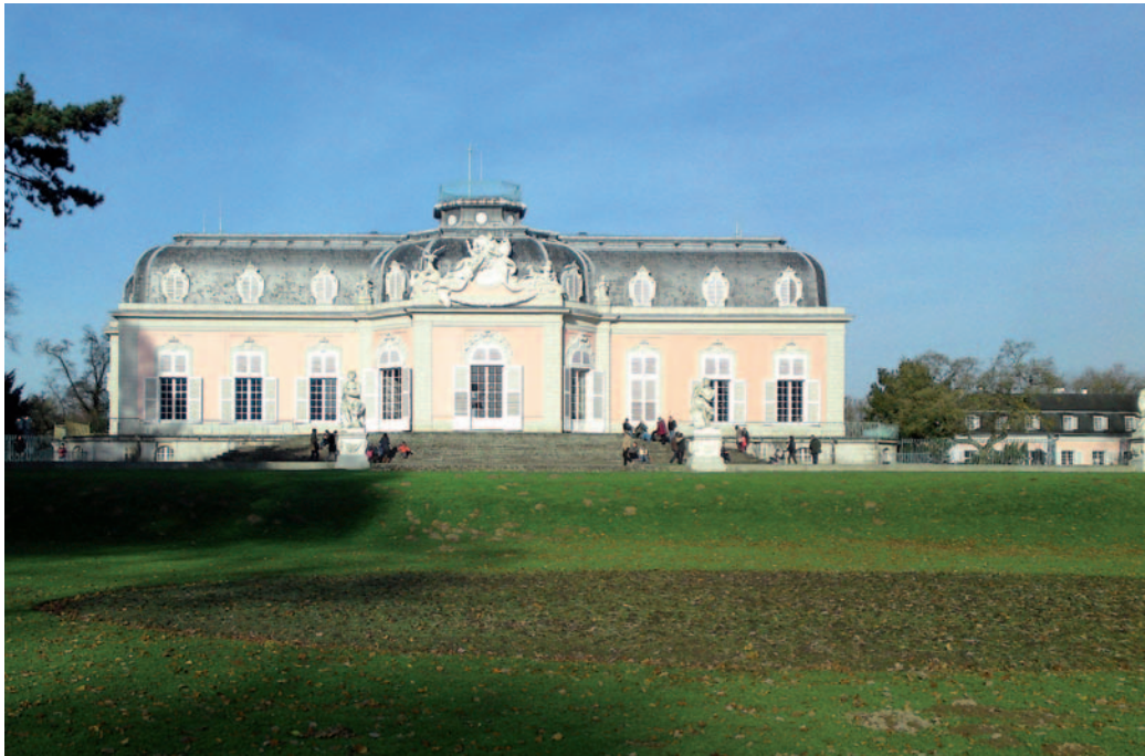
Das Hauptgebäude des Benrather Schlosses.
