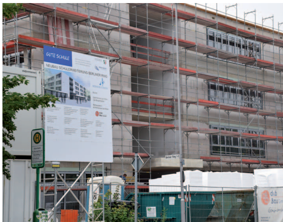
Das Schulzentrum am Berliner Ring wird bereits kräftig erweitert. Aus der Sekundarschule soll eine Gesamtschule werden. Foto: Norbert Jakobs
